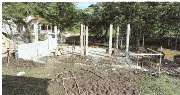
Foto1: COLOCACION DE BLOK PARA EL MURO.
