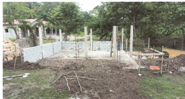
Foto 2: COLOCANDO COLUMNA PARA EL CORREDOR.
