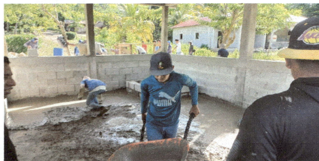
Foto 5: TIRANDO CONCRETO PARA EL PISO
