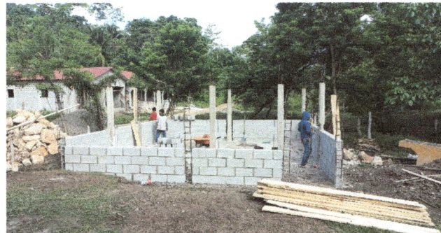
Foto 4: COLOCACION DE DIVISION DEL MURO.
