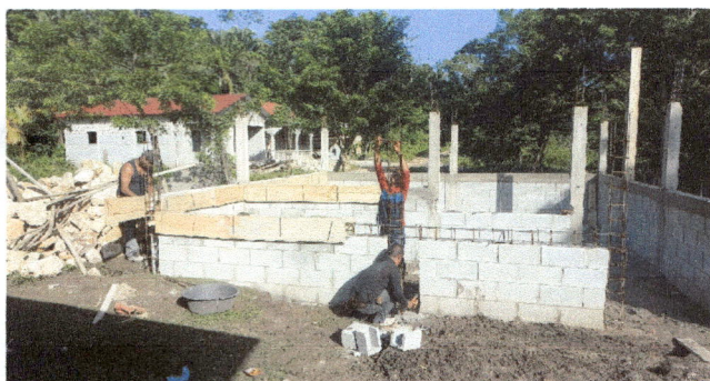
Foto 3: TERMINANDO LA COLOCACION DE MUROS.
